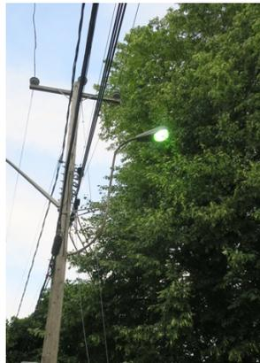
*Figure 37 : Éclairage de type tête de cobra*
