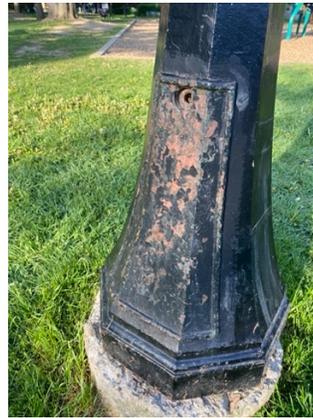
*Figure 24 : Corrosion sur la porte du fût*
